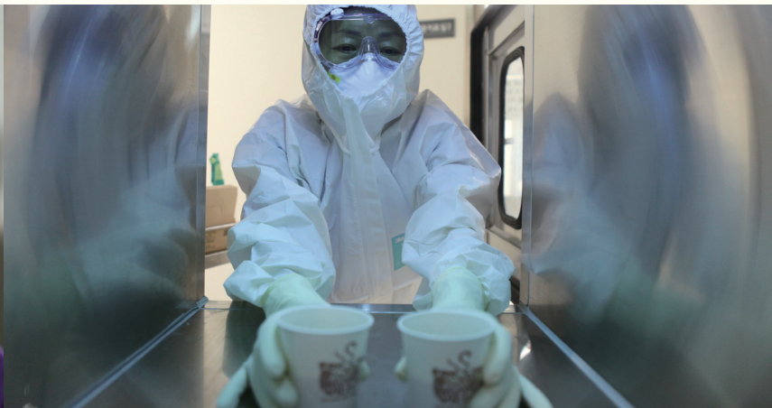
외부와 음압설비로 차단된 물품이동 통로(Pass Box)를 통해 환자에게 전해줄 커피를 전달받고 있는 격리병동 간호사. Pass Box는 격리실 안쪽과 바깥쪽에 문이 있어 각각 여닫게 되어있으며 공기의 흐름은 항상 격리실로 흐르게 해 공기 중 바이러스가 외부로 나오지 못하도록 되어있다.
